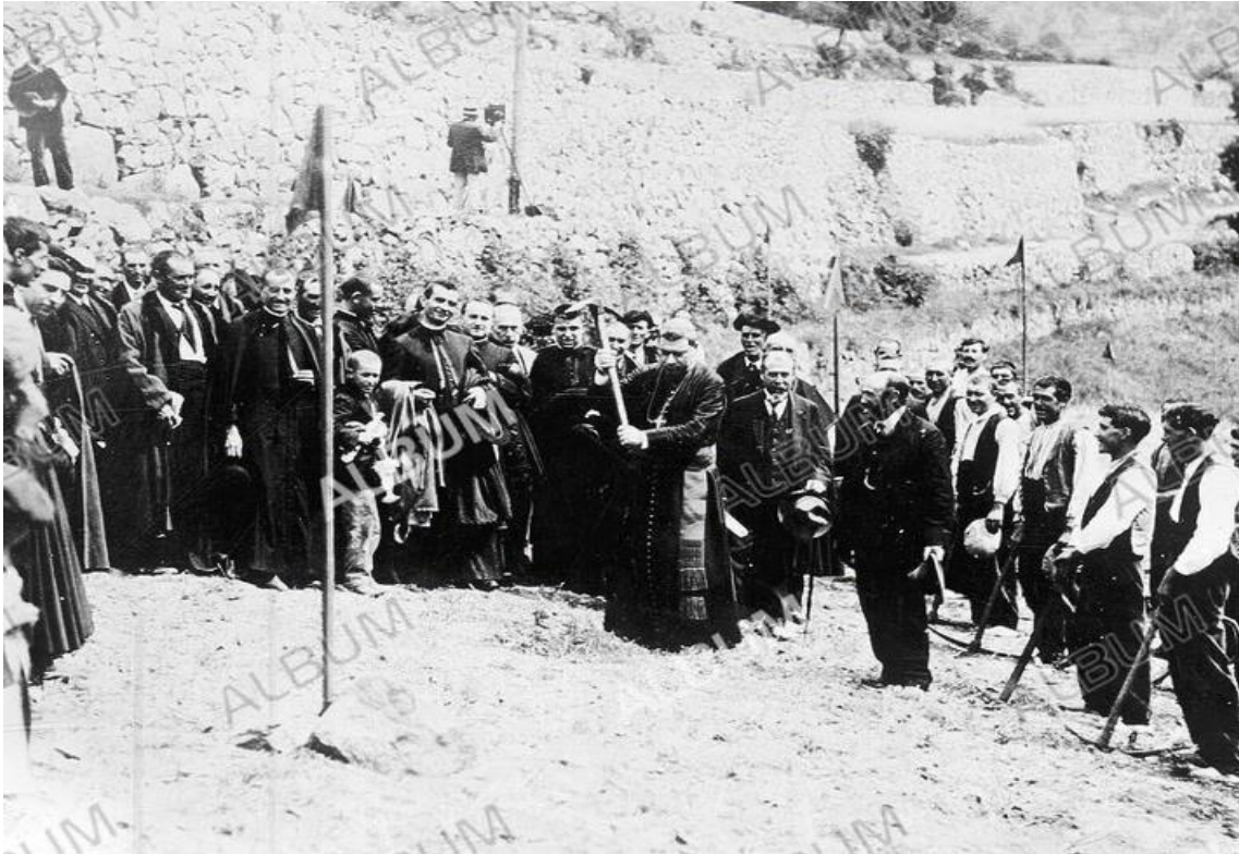
1/8/1913: El Bisbe Benlloch dona el primer “cop de pic” dels treballs de la ctra. d’Andorra la Vella a la frontera espanyola.
